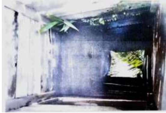
Gambar 3 Kondisi Sumur Gali
