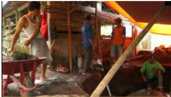
Gambar 1. gotong royong pembangunan instalasi biogas
