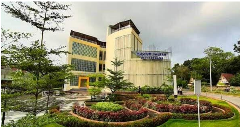
(Gambar 1. Foto Bagunan Museum Kabupaten Deli Serdang Sumber Foto Pribadi Diambil hari kamis , 23 April 2026, Pukul 12.00 WIB)
